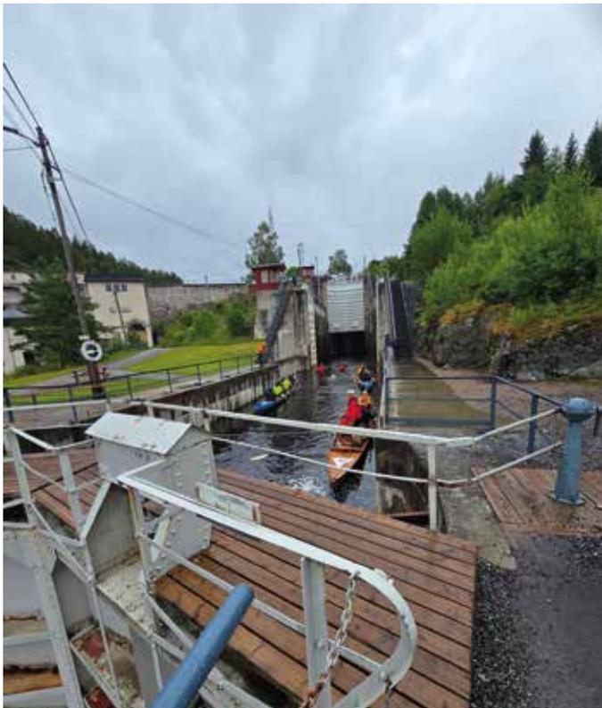
**Höhenrekord:** Mit vier Schleusenkamern und einem Hub von fast 27 Metern ist die Schleusenanlage Brekke die höchste in Nordeuropa.
