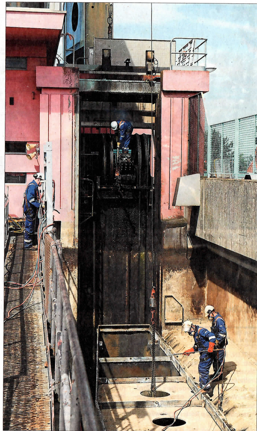
Arbeiten an der Straßburger Schleuse
